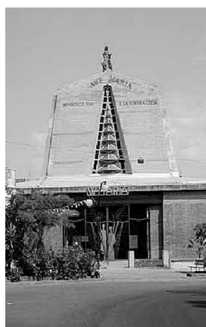
Piazza Caduti del Mare, zona interessata ai lavori per la rete fognante
