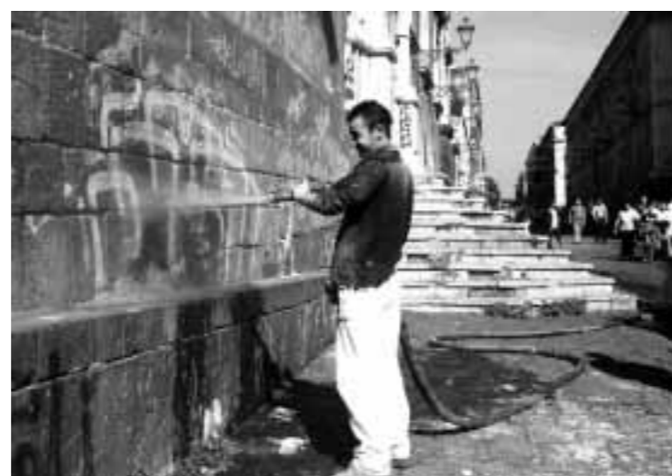
GETTI D'ACQUA AD ALTA PRESSIONE PER SCIOGLIERE LA VERNICE
