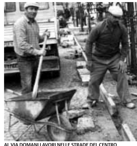
AL VIA DOMANI LAVORI NELLE STRADE DEL CENTRO
