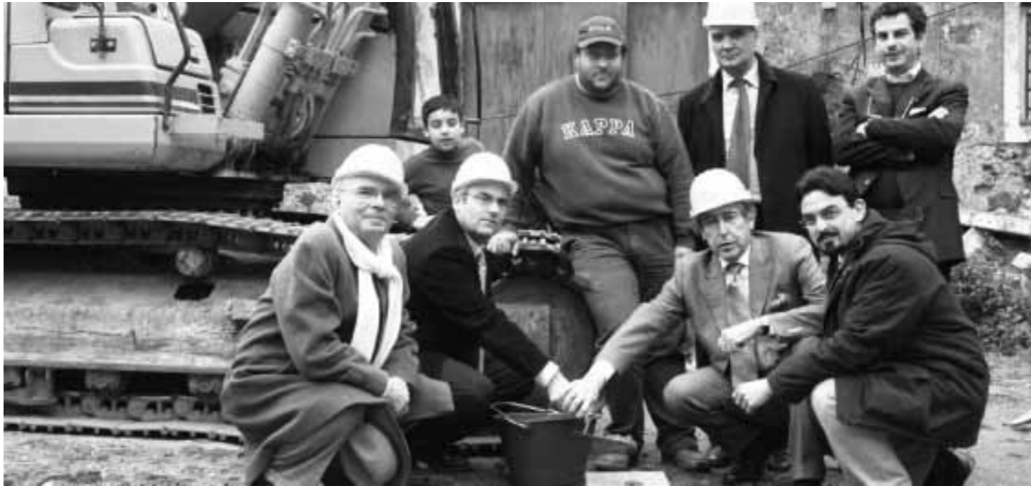
IL SINDACO SCAPAGNINI E L'ASSESSORE D'ANTONI DURANTE LA POSA DELLA PRIMA PIETRA DELLA NUOVA PIAZZA. NELLE ALTRE DUE FOTO L'AREA INTERESSATA [FOTO D'AGATA]
